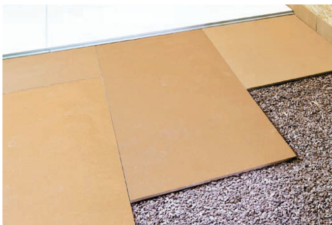
Zur Bodensanierung wurde eine Kombination aus Cemwood-Ausgleichsschüttung und Norit-Trockenestrich eingesetzt.
